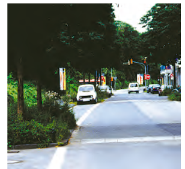
Bild 14: Teilaufpflasterung in Asphalt mit S-förmigen Rampensteinen
