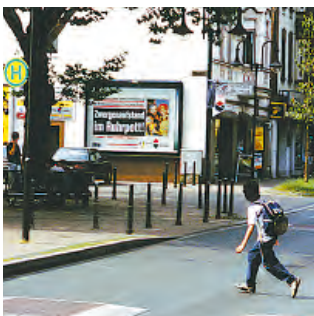
Bild 15: Plateaufpflasterung mit Rampensteinen
